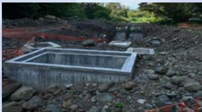
Trabajos en Área de Desarenado
