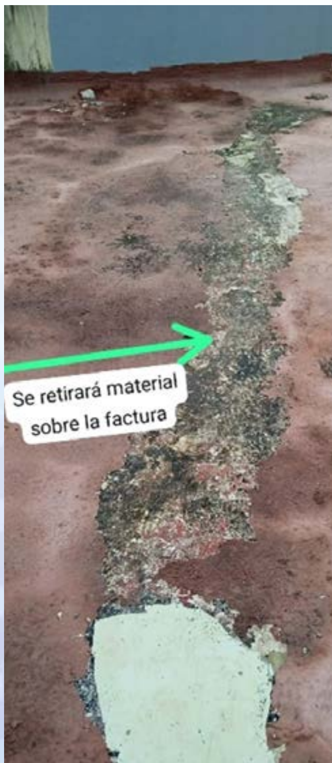
Mantenimiento y aplicación de sellador impermeabilizante en la losa
