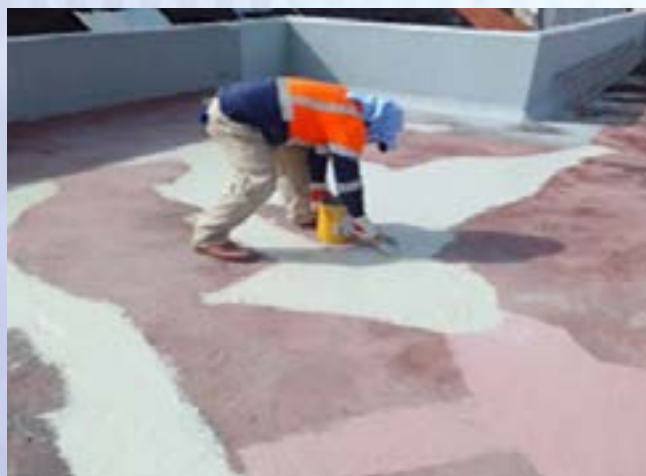
Mantenimiento y aplicación de sellador impermeabilizante en la losa
