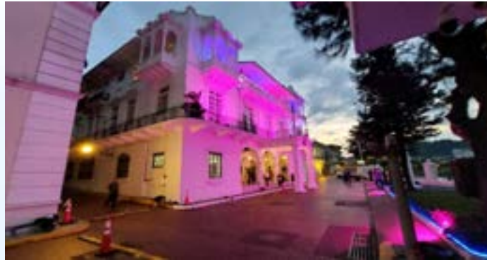
Área: Calle 6ta, Edificio Casa Alianza. Colaboración con la Empresa Naturgy
