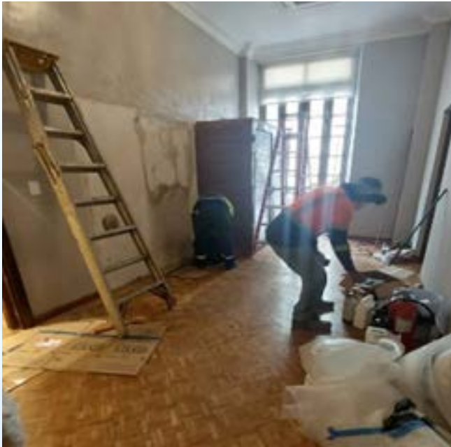
Desinstalación de closet, resane y pintura, entre otros.
