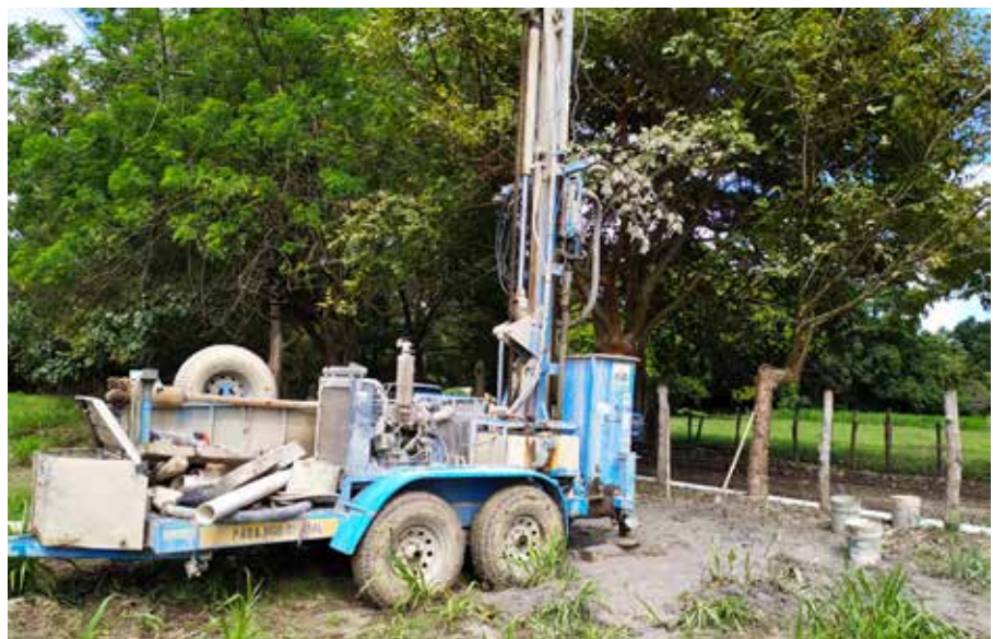
El MIDA cuenta con equipo y cuadrillas para apoyar a los productores.
