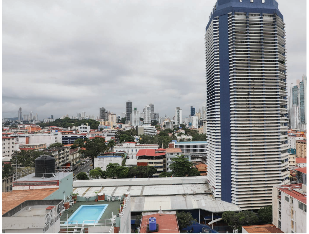
La última vez que se pintó este emblemático edificio, que se construyó en la década de 1970, fue en el año 2012.
