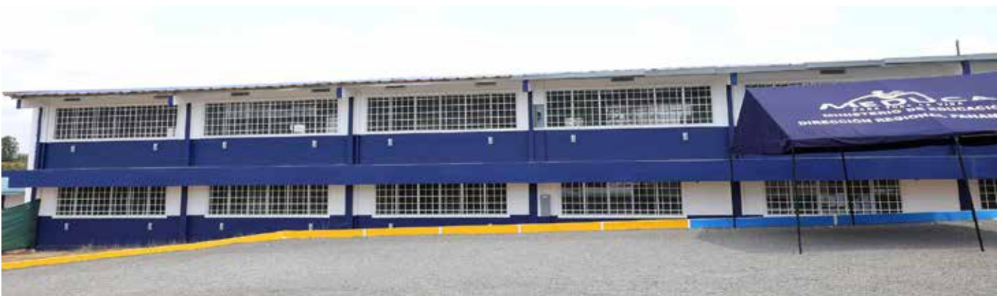
La obra, con inversión 13.6 millones de balboas, registra un avance de 52%.
