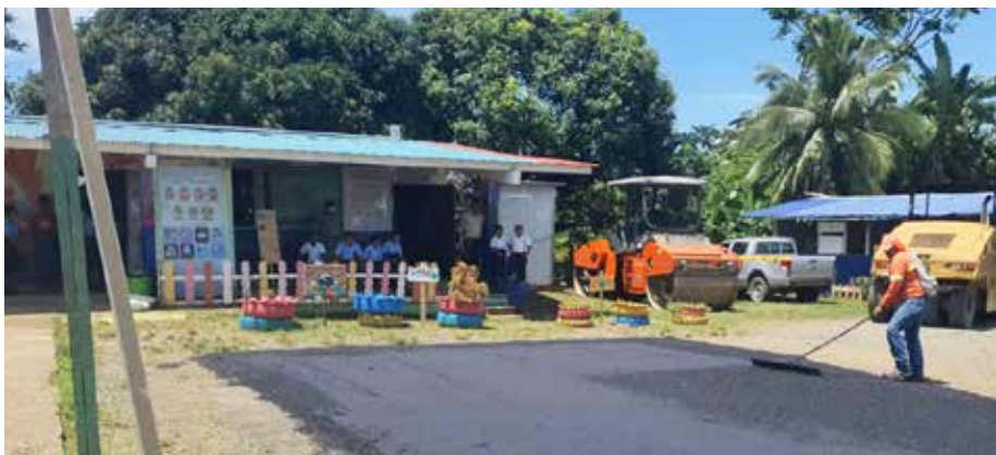
Colocación de carpeta asfáltica en Loma Estrella - Tierra Oscura, en Almirante, Bocas del Toro.
