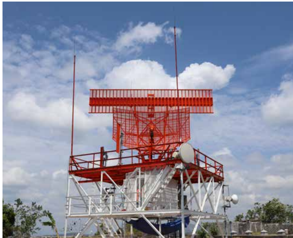
Instalación de antena de radar primario y secundario.
