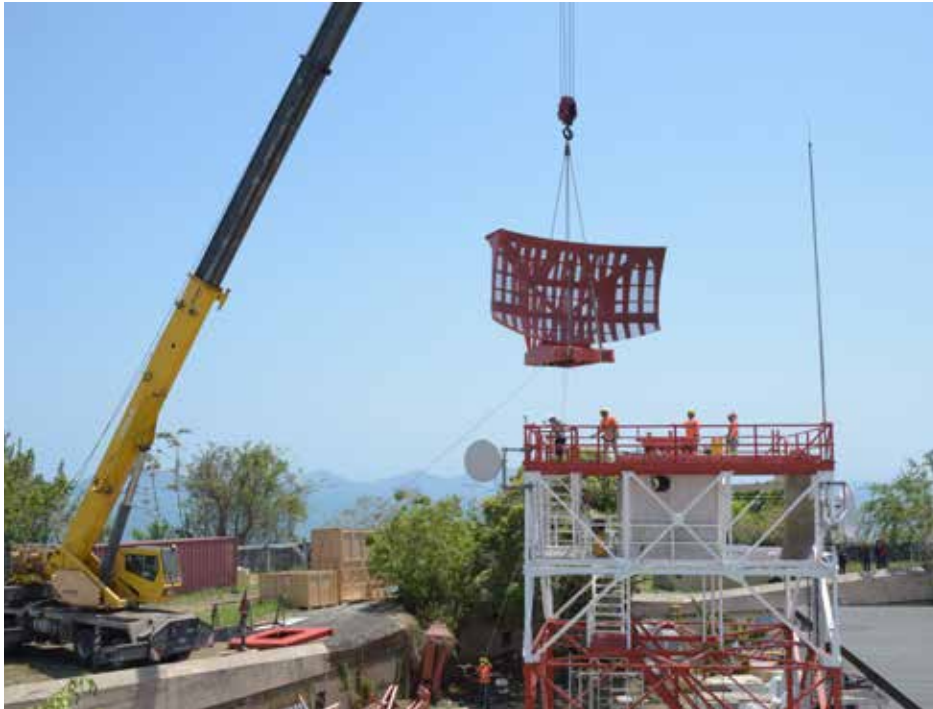
Sistema comontado de radar primario 2D y un secundario con sistema ADS-B.
