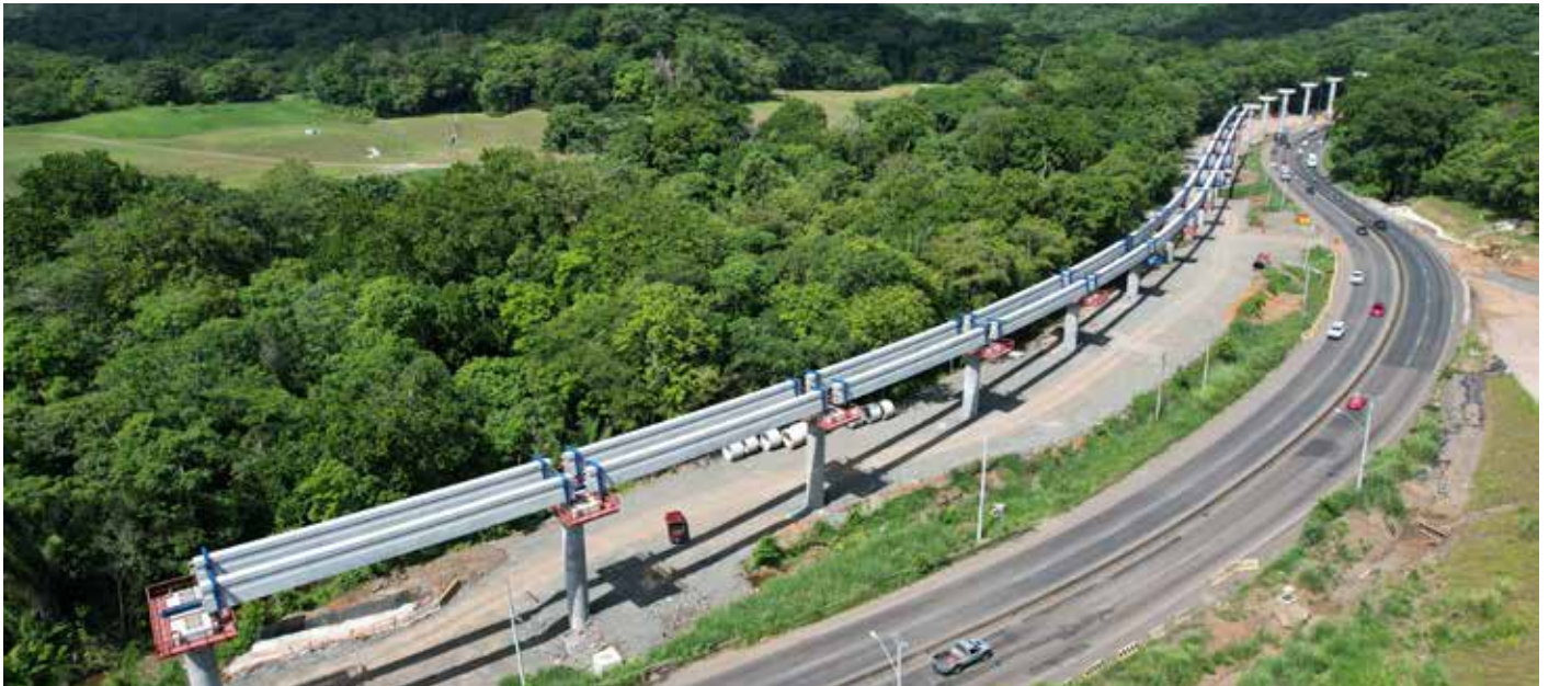
Trazado del viaducto a lo largo de la carretera Panamericana.
