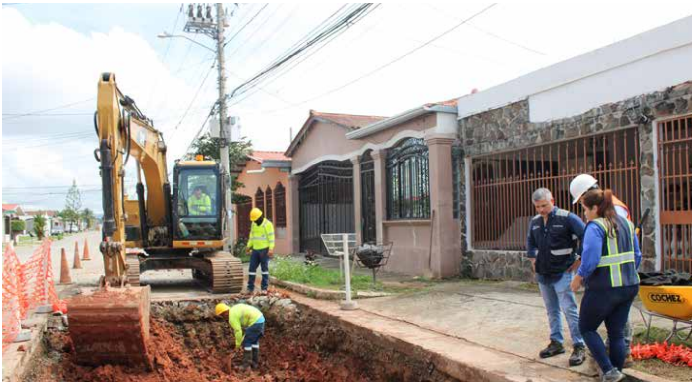
Trabajos del Renglón 3 del proyecto calles de Panamá, en la Avenida Tercera - Villas de Don Bosco.
