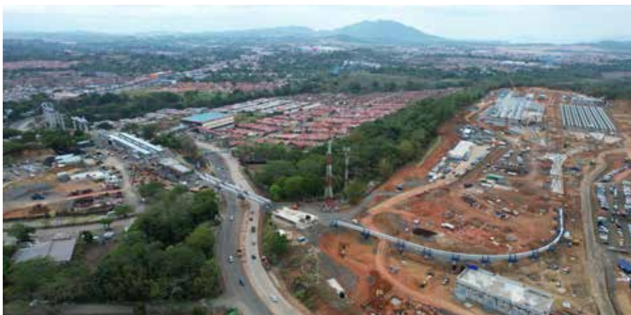
El corazón de la Línea 3 se concentrará en el área de Patios y Talleres, donde se realizarán las principales labores para el buen funcionamiento del monorriel.
