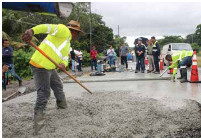
Durante estos días, los trabajos han consistido en la remoción de pavimento, material selecto y capa base, y se aplicó la primera capa de asfalto.
