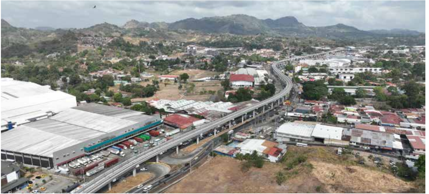
Viaducto que conectará las estaciones San Isidro y la nueva estación Villa Zaíta.
