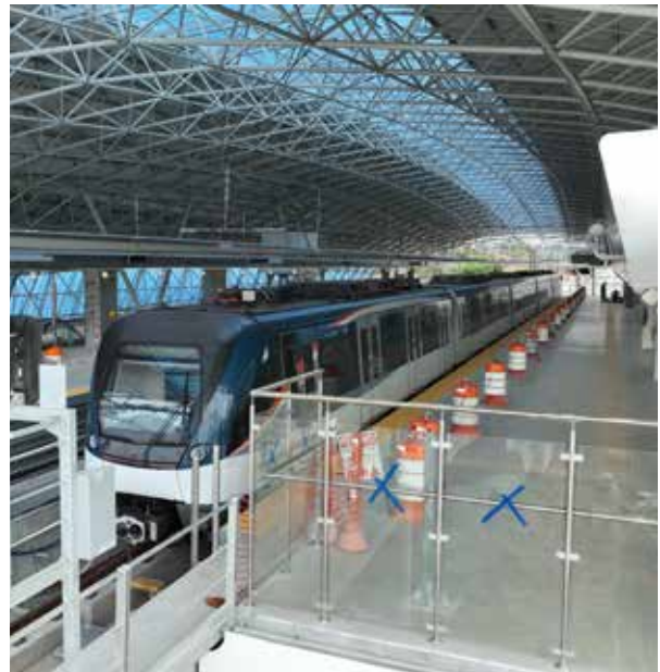
Prueba de movimiento de trenes en la nueva estación.
